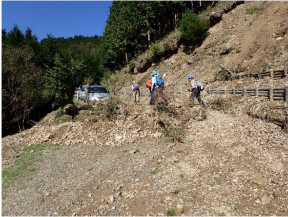
土砂崩れ箇所
